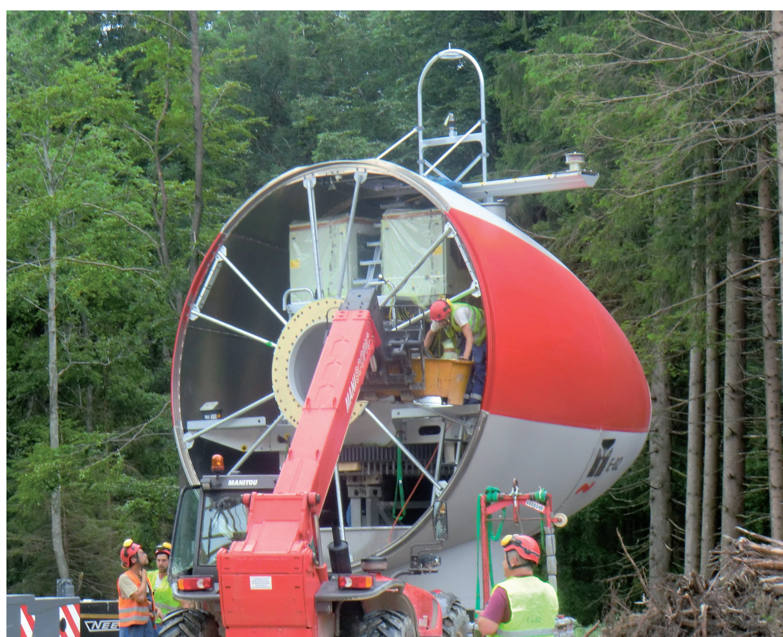
Gondelquerschnitt E-82 / 2300 kW Quelle: ENERCON GmbH
