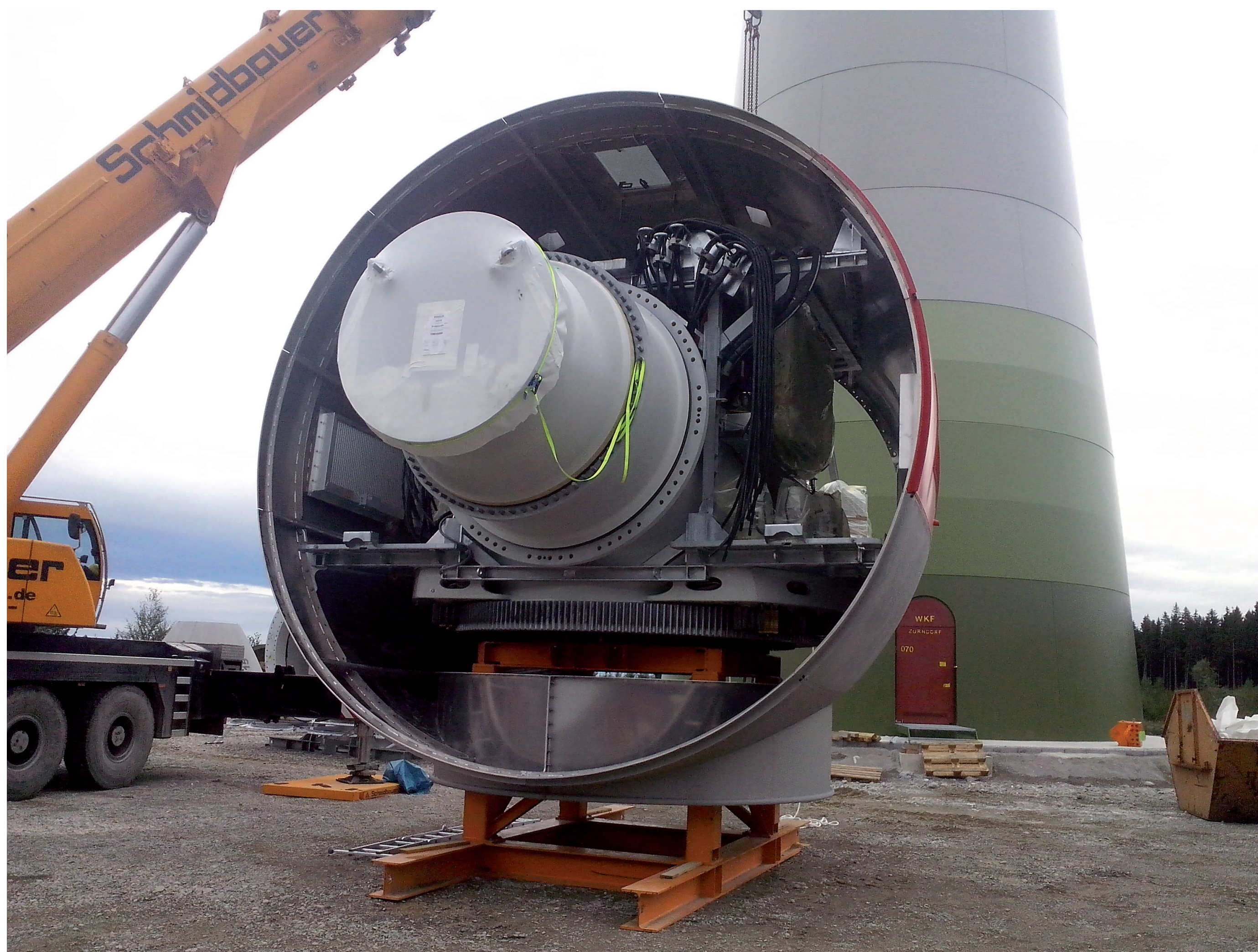
Baustelle „In der Höll Nord“ im September 2015
